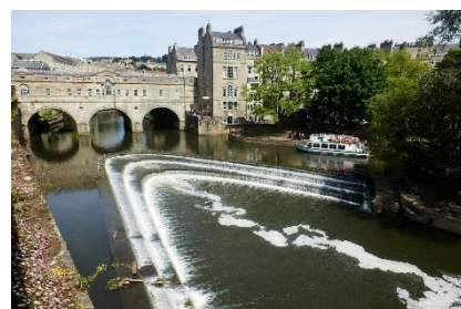
ブルトニー橋と前面の堰
