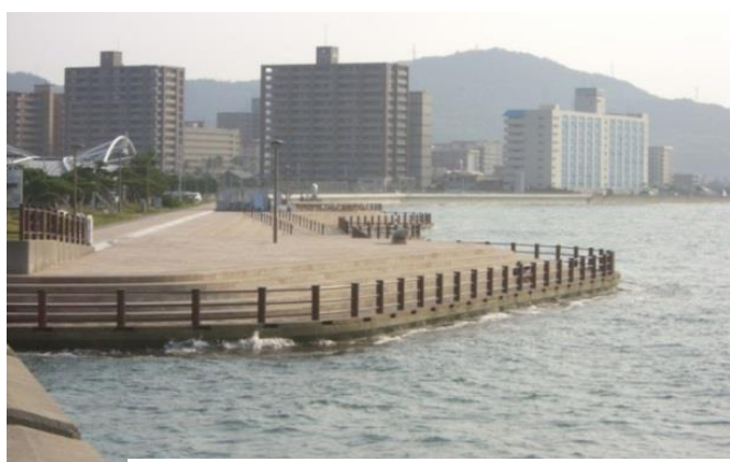
写真 13 市民の散歩道・親水機能を有する防波護岸と防波堤 (防波空間と利用空間が融合した高松港サンポート地区：四国地方整備局施工)
