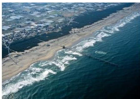
写真9 東日本大震災時に津波高さ5mにも耐え、28年間漂砂を観測し続ける波崎観測栈橋(延長427m)
