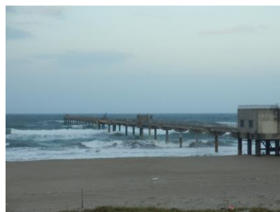
写真9 東日本大震災時に津波高さ5mにも耐え、28年間漂砂を観測し続ける波崎観測栈橋(延長427m)
