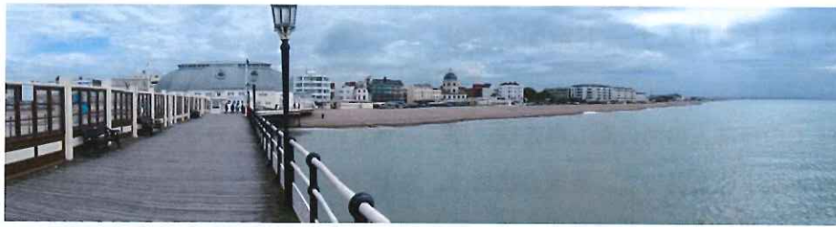
ワーシング栈橋
