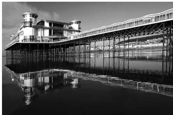
写真5 杭構造の軽やかさが印象に残る（ウェストン・スーパー・メアのグランド栈橋）
