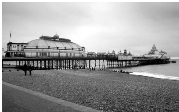
写真2 イーストボーン栈橋
