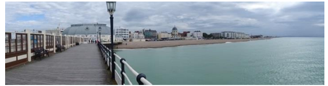
ワーシング栈橋
