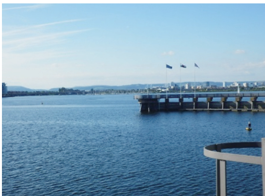
写真12 閘門を活用したカーディフ湾ウォーターフロントの再開発
