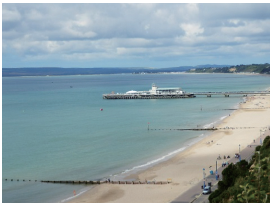
写真5 海浜安定化対策(ボーマス栈橋)
