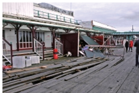
写真9 ブラックプール北栈橋を襲った高潮・高波被害(2013年12月)BBCニュース映像より
