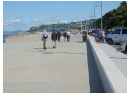
写真4 コルウィン・ベイ・ビクトリア栈橋周辺海岸 パターンII(海+遊歩道+防潮堤+道路+建物)
