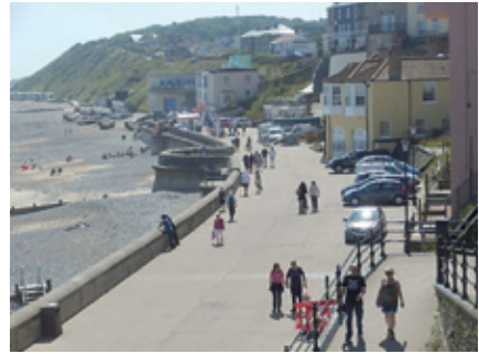
写真3 クローマー栈橋周辺海岸 パターンI(海+防潮堤+遊歩道+道路+建物)
