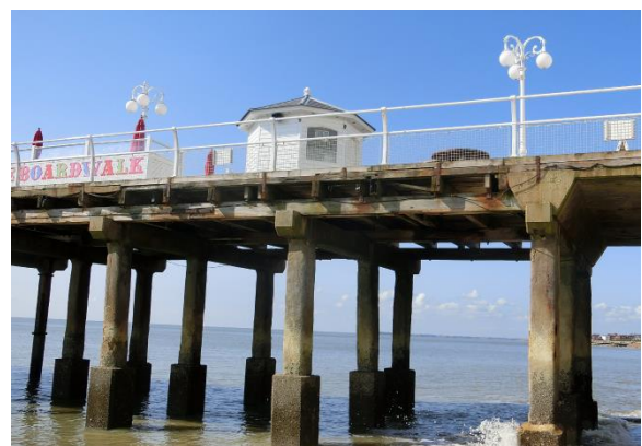
写真-8 フェリックストー栈橋下部工構造 (コンクリート製支柱)
