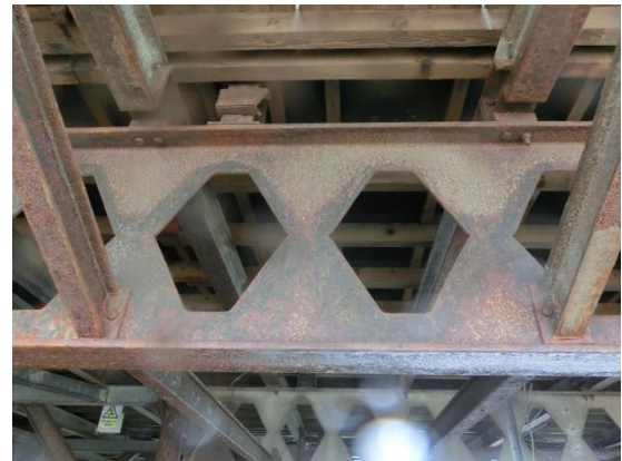
写真-2 ブラックプール・サウス栈橋上部工構造 (鋼製開口ウェブ桁)
