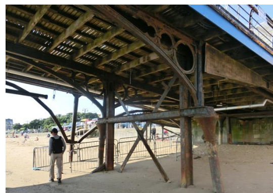
写真-4 クリーソープス栈橋上部工構造 (鋼製アーチ桁)
