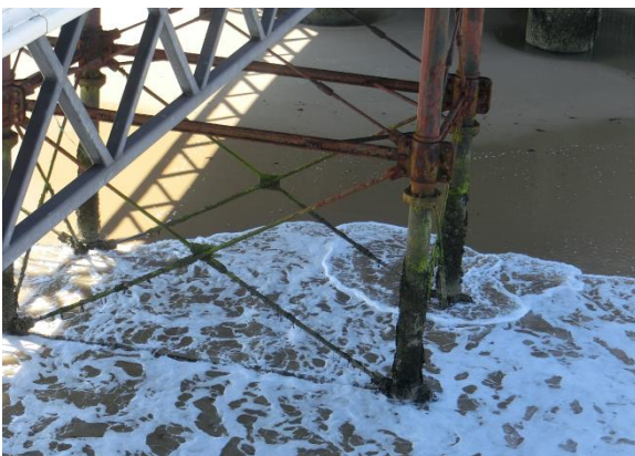
写真-9 クローマー栈橋下部工構造 (鋼管支柱+基礎)
