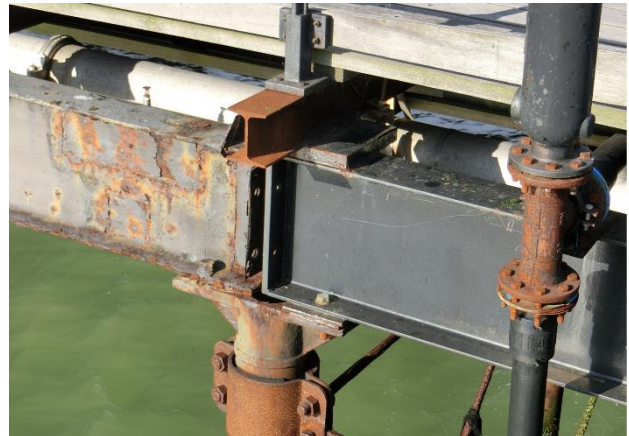
写真-12 サウスエンド栈橋主桁腐食 (左桁：腐食著しい、右桁：取替え後)
