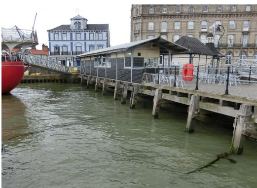
写真-3 ハリッジ栈橋上部工構造 (木製主桁)
