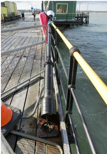
写真-11 サウスエンド栈橋照明の損傷 (仮囲いで規制)
