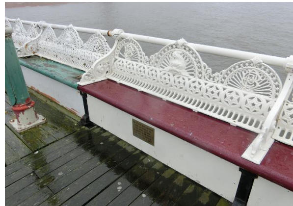
写真-16 ブラックプール・ノース棧橋 高欄ベンチ (地元からの寄贈プレート)
