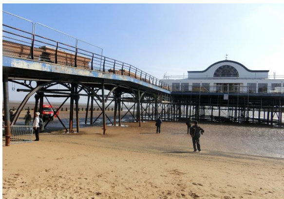
写真-13 クリープス栈橋 補修・改装工事中
