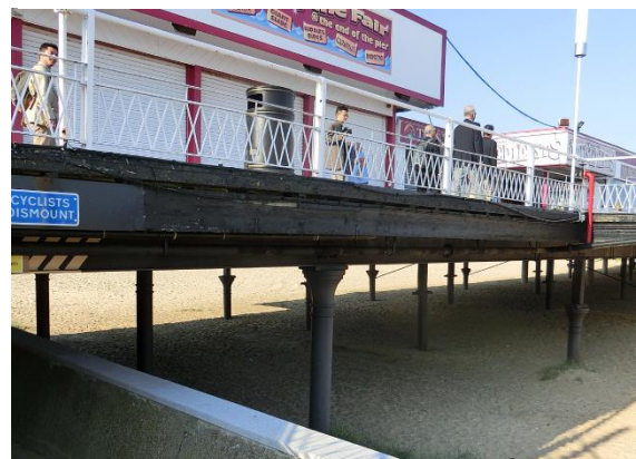
写真-10 グレートマスブリタニア栈橋下部工構造 (鋳鉄製鋼管杭)
