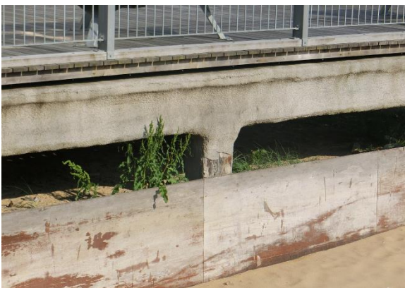
写真-7 グレートマスウェルトン栈橋下部工構造 (木製支柱外面吹付)
