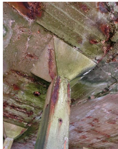
写真-14 クラクトン栈橋 床版と下部工の 断面欠損・腐食
