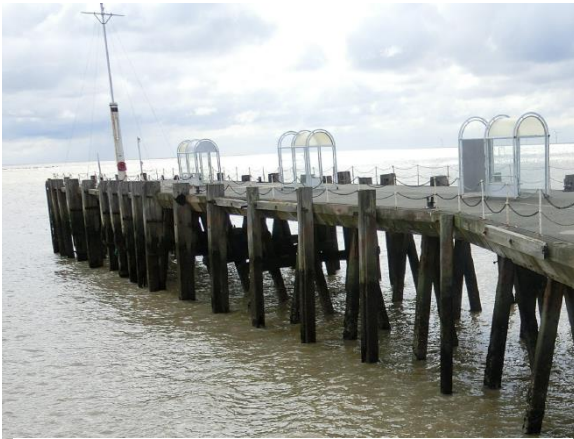
写真-5 クラクトン栈橋下部工構造 (コンクリート支柱+木製支柱外面貼り)
